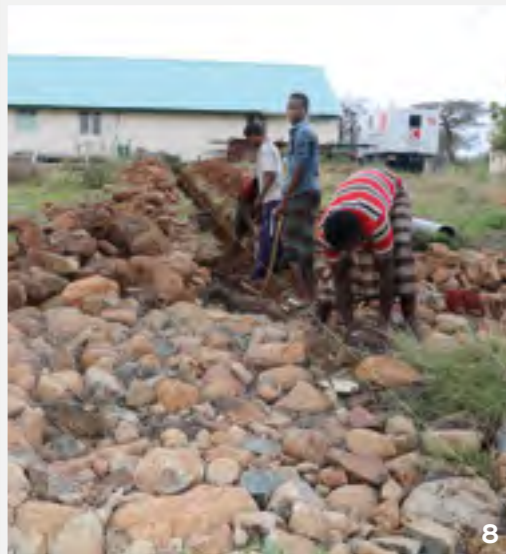
8 Mühsame Erdarbeiten im steinigen Klinikareal.
